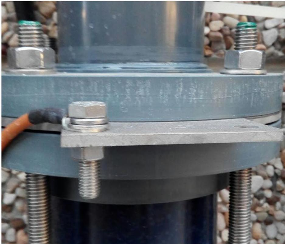
**Figura 3.4: Conexión a la célula de electrólisis**
