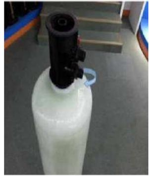
Paso 4: Atornillar el cabezal de distribución en la válvula de control (con bypass), luego atornille los componentes montados en el conector del tanque paralelo
