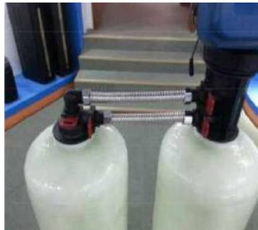
Paso 6: Conecte la válvula check de 3/8 "al codo de extracción de salmuera, la válvula check de 3/4" a la entrada del bypass
